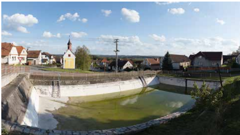
Rybníček Sázka dnes slouží jako požární nádrž (Foto Kurz, duben 2018)
