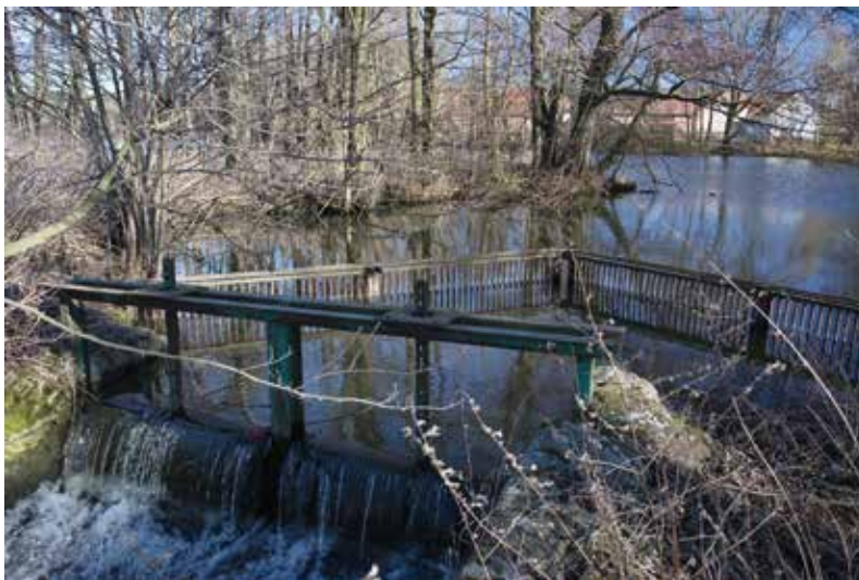
Bezpečnostní přeliv Hajanského, kterým vytéká voda do Řečického (Foto Kurz, leden 2018)
